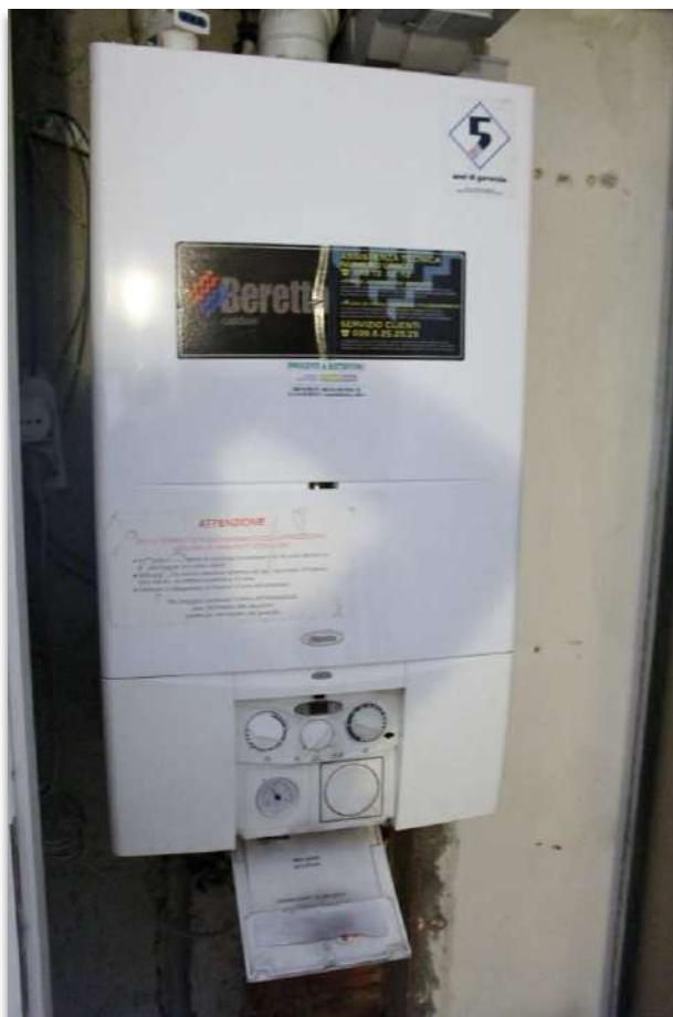
Foto 32 – Vista della caldaia per il riscaldamento e per la produzione di a.c.s. collocata all'interno di un copricaldaia in cartongesso posta nel vano 5
